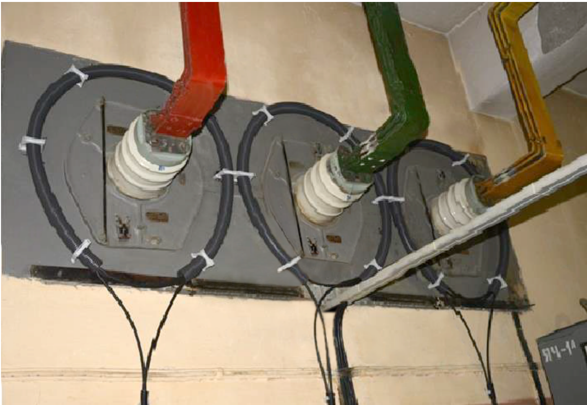
Рис. 3. Трансформаторы тока в виде гибкой чувствительной петли
